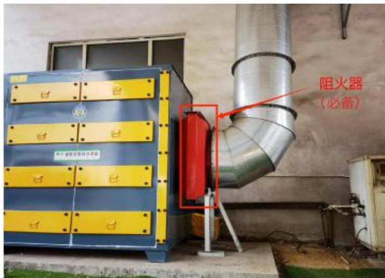
防火阀（安全阀）安装示意图
