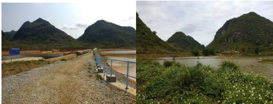
图 4-20 庞凌河和龙山排泥库应急池
