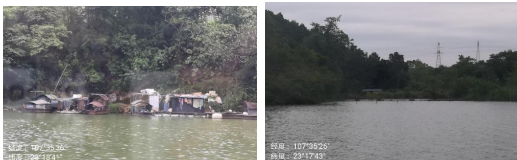
图 4-11 现场勘查沿河居民和散养问题
