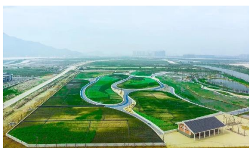
污水处理厂尾水处理工程实拍图
