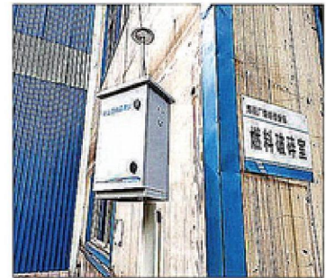
易产生尘区域扬尘监测
